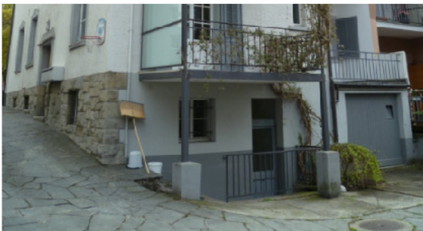
Klosbachstr. 141, 8032 Zürich (links Gesamt-Haus-, rechts Keller-Eingang)
